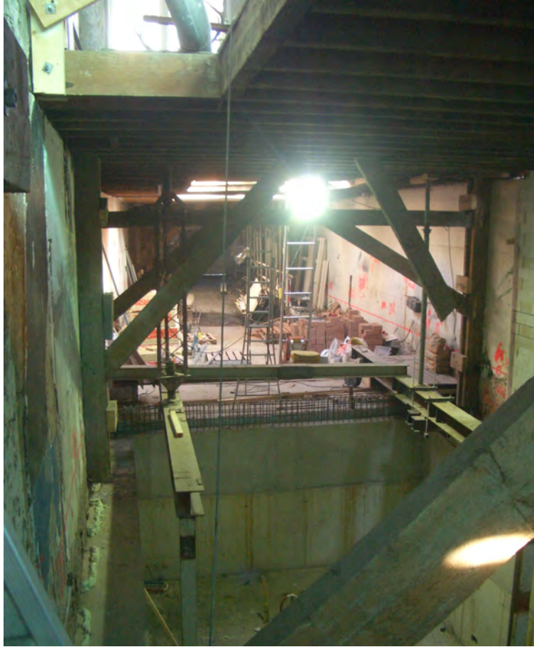
Foto derzeitiger Stand der Bauarbeiten
